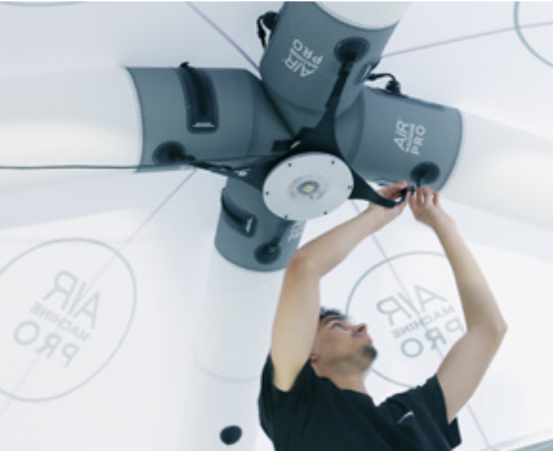
Einfache Montage der Deckenbeleuchtung
